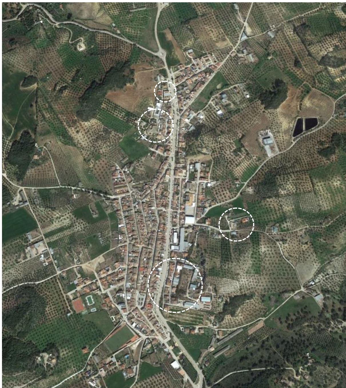
Sectores con deficiencias de estructura viaria – Google Earth © 2021
