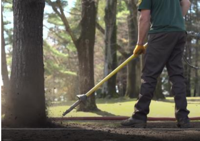
Imagen 29. Descompactación del terreno con Air Spade (Fuente:www.airspade.com)
